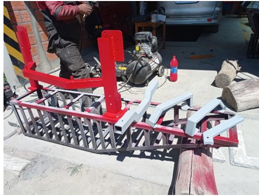
Figura N° 18 bañado de pintura a piezas de soporte
