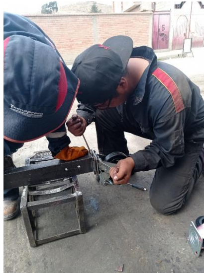
Figura N° 17 Armado de soporte
